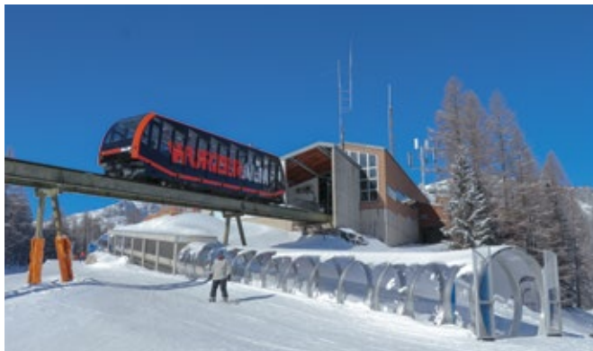
CUSTOM SOLUTIONS DES SOLUTIONS SUR MESURE
