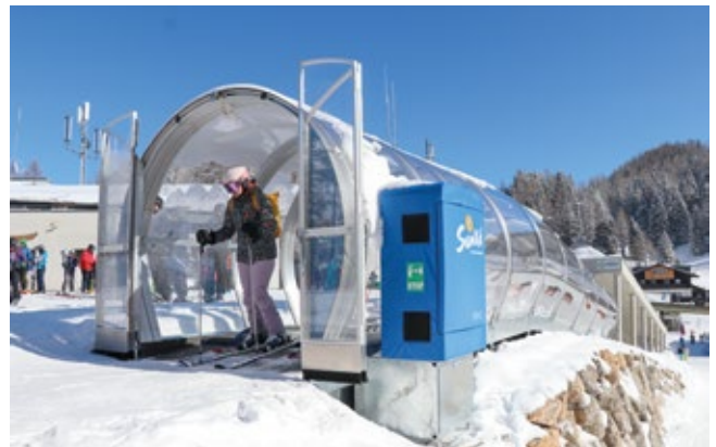
Double door for entry and exit Double porte pour l'entrée et la sortie
