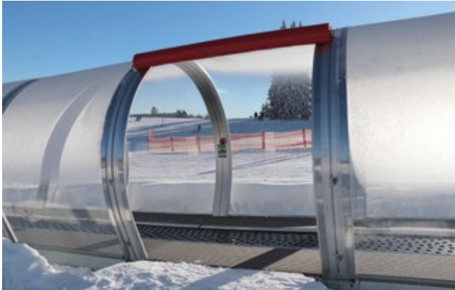
Emergency exit with PVC tarpaulin – here in a customized color Issue de secours avec bâche en PVC – ici dans une couleur spécifique au client
