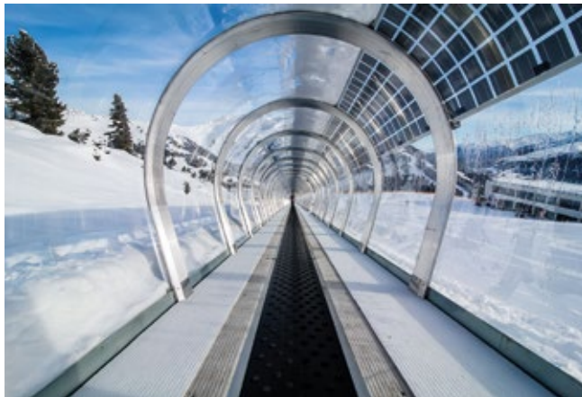
Photovoltaics integration | Intégration photovoltaïque
