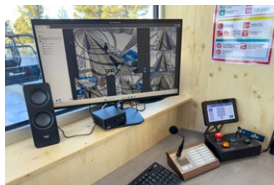
Externe Bedienterminal: Betrieb und Überwachung des Zauberteppichs in der Bergstation einer benachbarten Liftanlage
